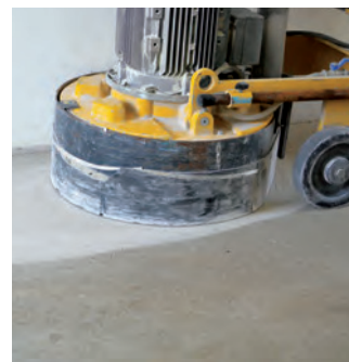
Priprava podlage z brušenjem
