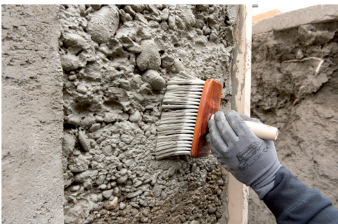
Po premazu armature se okoliško zidovje skrbno navlaži in skrtači z lepilno goščo (lepilna gošča Repol HS 1).
