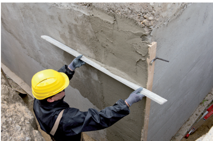
Po prevleki s sanacijsko malto se nanese polnilna masa za beton (Repol BS 05 G, Repol BS 10 W) v potrebni debelini sloja.
