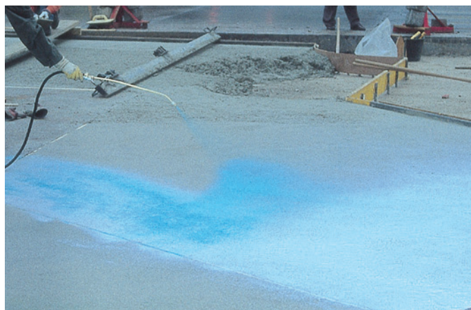
Takoj po nanosu se nanese oziroma nprši še zaščita pred izhlapevanjem.
