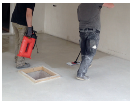
Impregnacija za beton TE 18 se naprši in porazdeli z metlico.
