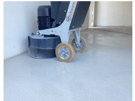
Brušenje je namenjeno za zapiranje por.
