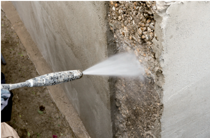
Podlaga se predhodno obdela z visokotlačno napravo za vodo.
