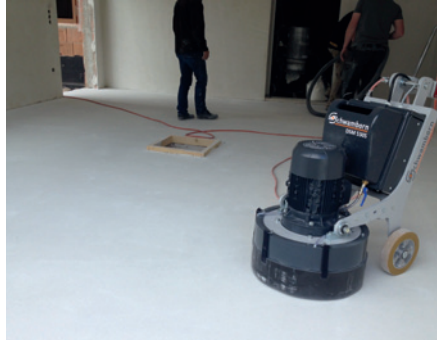
Tla se zbrusijo z diamantno brusilno napravo.
