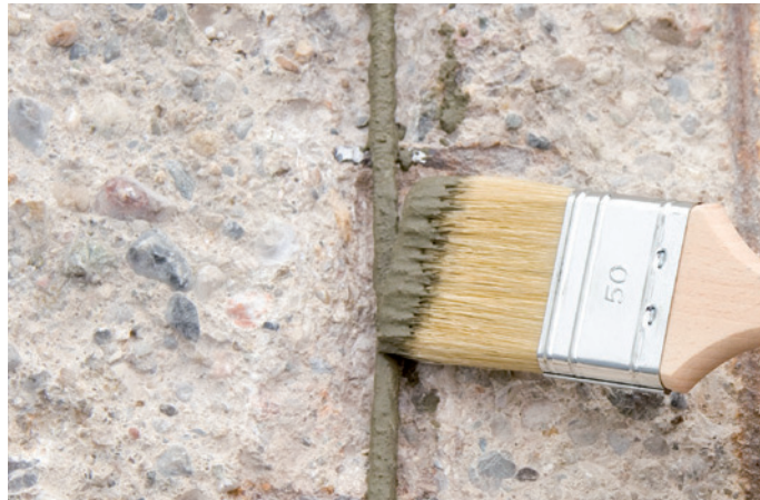
Po končanem delu in čiščenju armature se nanese zaščita za armaturo (zaščita za armaturo Repol BS 7).
