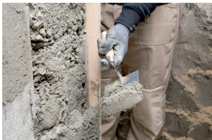
Po krtačenju lepilne gošče Repol HS 1 se mokro nanesejo lahka malta Repol LM 20 light, sanacijska malta Repol SM 20, sanacijska malta Repol SM 40 v ustrezni debelini sloja.
